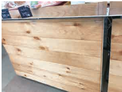
パン屋さんの雰囲気をだすため 無機質な什器に木目のシートを設置します
